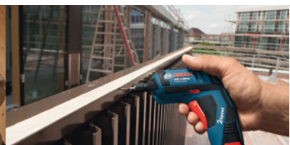
Phase 3 – Travaux de finition
